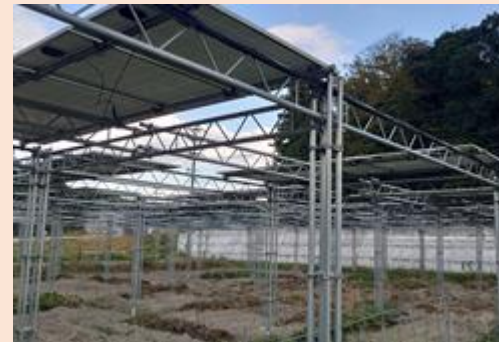
営農型太陽光発電(ソーラーシェアリング) Agrivoltaic power generation (Solar sharing)
